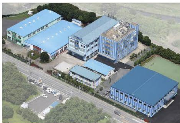
日高・川越工場全景
